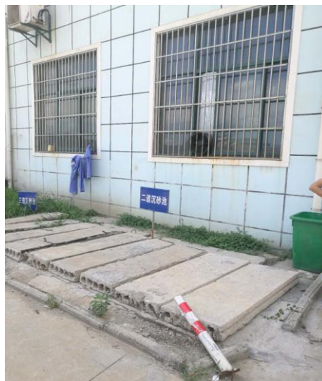
二道沉砂池、三道沉砂池
