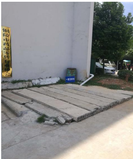
一道沉砂池及入水管
